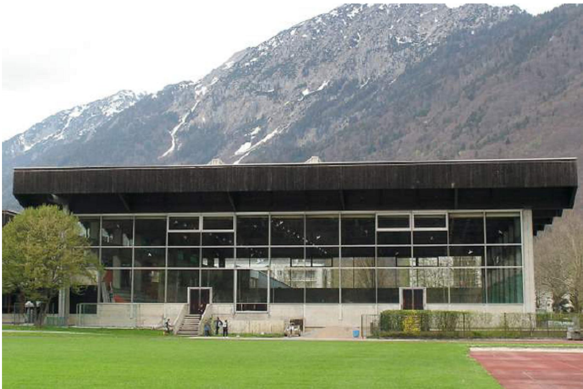
Bild 1: Eissporthalle in Bad Reichenhall, Ansicht der schmalen Front
