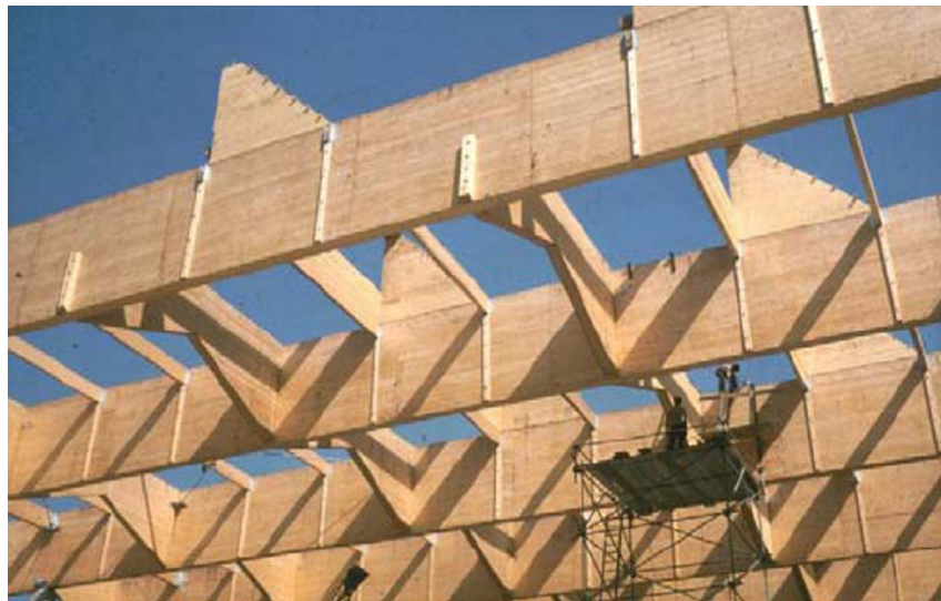
Bild 3: Hölzernes Dachtragwerk im Bauzustand
