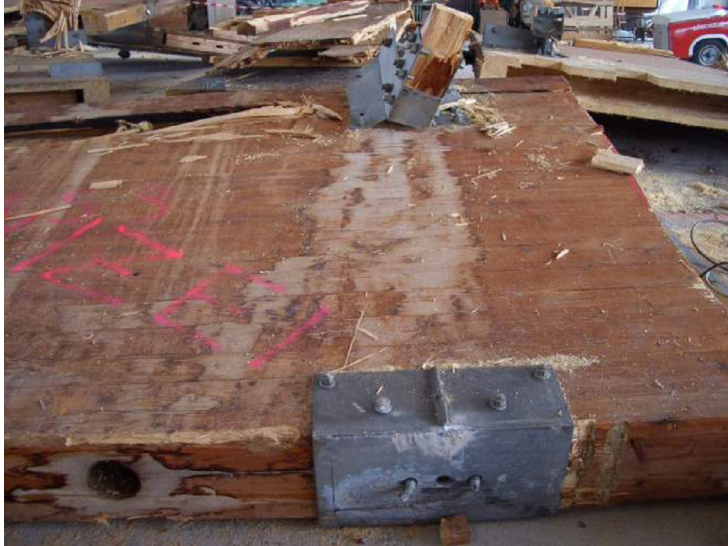
Bild 6: Aufgebohrte Gurte, um die Regenfallrohre unsichtbar im Innern der Binder zu führen
