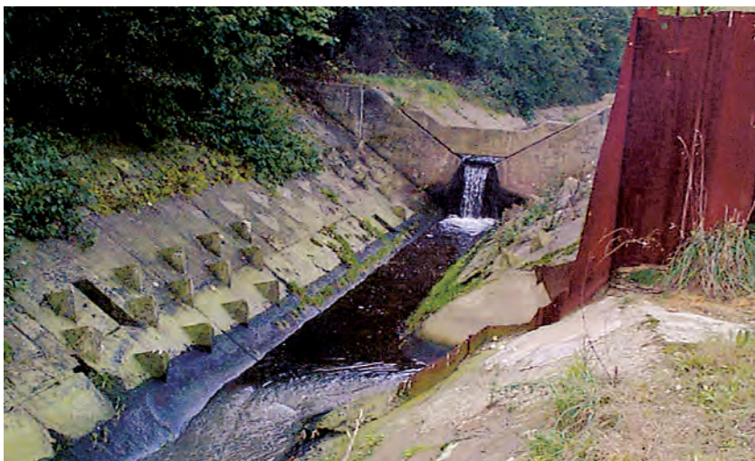
Abb. 3.1.5-3 Boye mit Sohl- schalenverbau und Ein- leitungsbauwerk (rechts)
