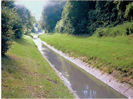
Abb. 3.1.5-1 Emscher mit Sohl- schalenverbau (Quelle: © Emscher- genossenschaft)
