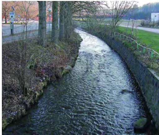
Abb. 3.1.5-1b Rechts: Erftflutkanal, angelegt zur Abführung von Sumpfungswässern
