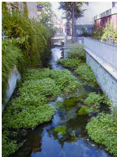
Abb. 4.1.2.1-4 Offen gelegter Soestbach im Stadtgebiet Soest unterhalb Kohlbrink (Foto: Ing.-Büro Stelzig, Soest)
