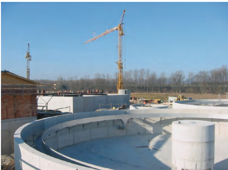
Abb. 3.1.1.1-3 Bau der Kläranlage Anröchte (Foto: Gemeinde Anröchte)
