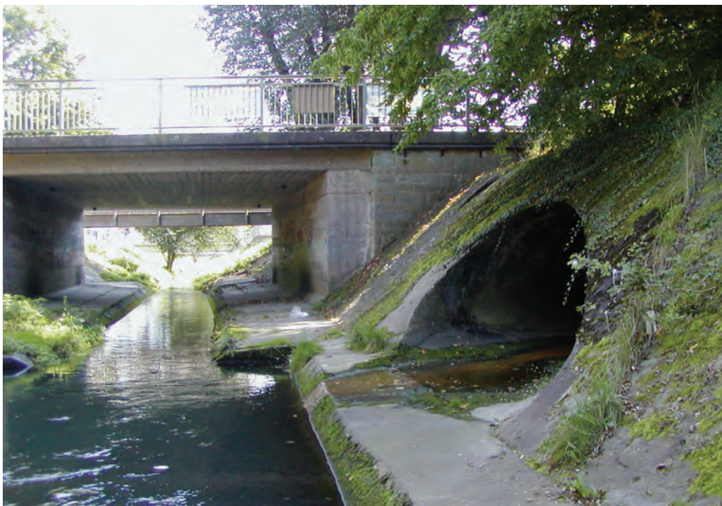
Abb. 3.1.1.3-2 Regenwassereinleitung in den Soestbach (Foto: StUA Lippestadt)
