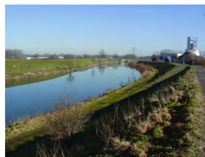
Abb. 2.1.3.3-3 Eingedeicherter Lippe- abschnitt in Hamm, Strukturgütekategorie 6 (Foto: StUA Lippstadt)
