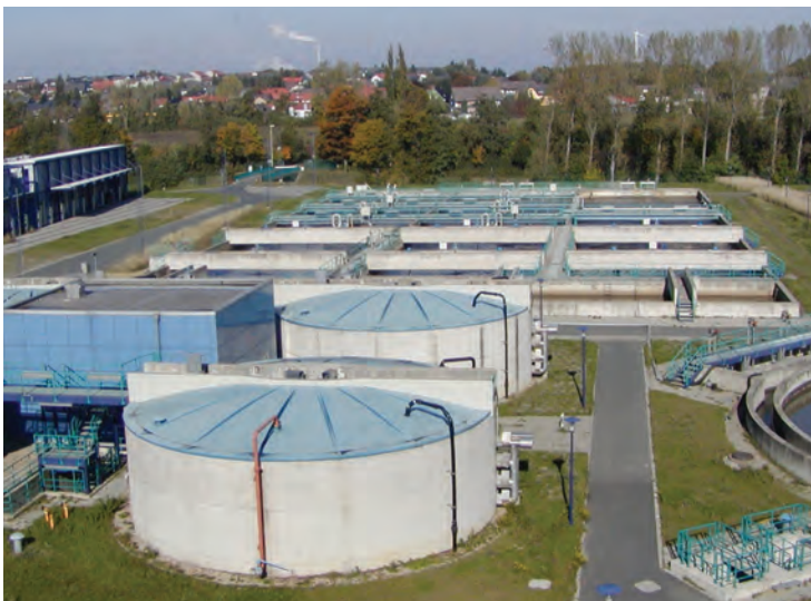
Abb. 3.1.1.1-1 Kläranlage Kamen (Foto: StUA Lippstadt)
