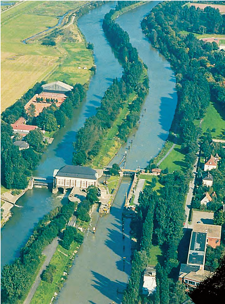
Abb. 3.1.4-2 Lippewasserüberleitung bei Hamm (Foto: WSD West)
