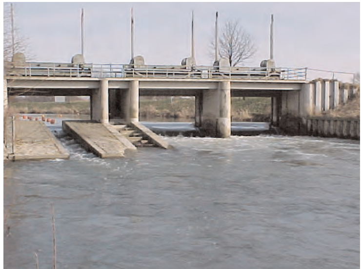
Abb. 3.1.6-1 Querbauwerk in der Lippe bei Lippstadt-Esbeck mit Bootsgasse (links) und Fischaufstieg (Foto: StUA Lippstadt)
