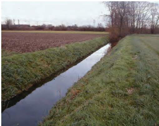
Abb. 3.1.5-3 Für die Landwirtschaft ausgebauter Salzbach nördlich von Werl-Büderich (Foto: StUA Lippstadt)
