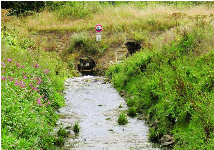
Abb. 3.1.1.3-1 Größenverhältnis zwischen Kläranlagen- einleitung (links) und Einleitung aus RÜB an der Kläranlage Hattingen (Foto: StUA Hagen)
