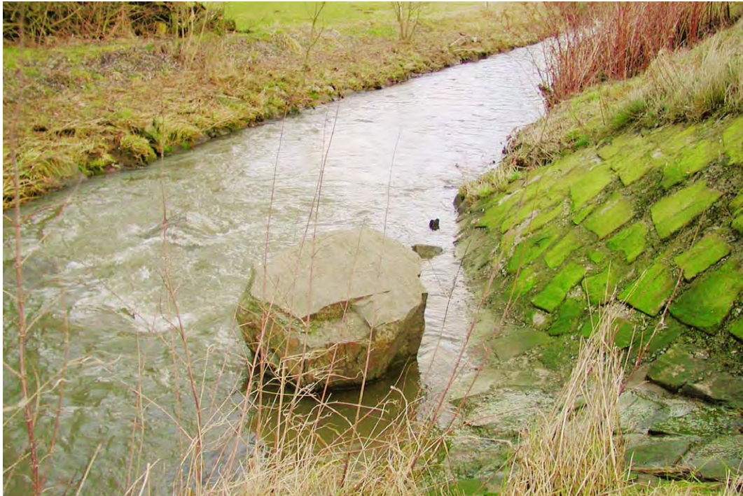
Abb. 4.1.2.1-7 Einleitung aus der RÜB-Kläranlage in den ausgebauten Baarbach (Foto: StUA Hagen)
