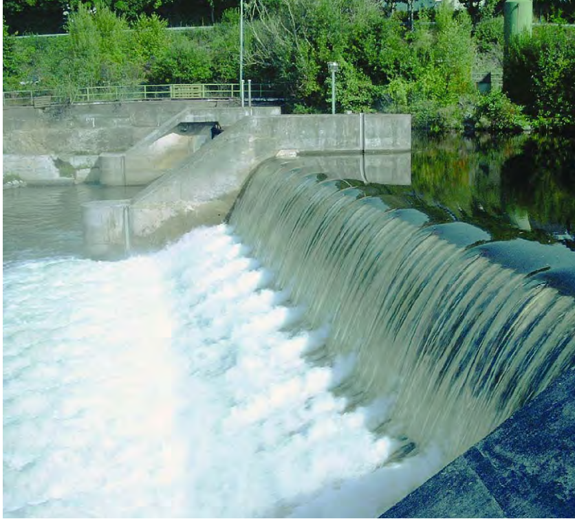
Abb. 3.1.6-2 Wehranlage Lang- schede (Foto: StUA Hagen)
