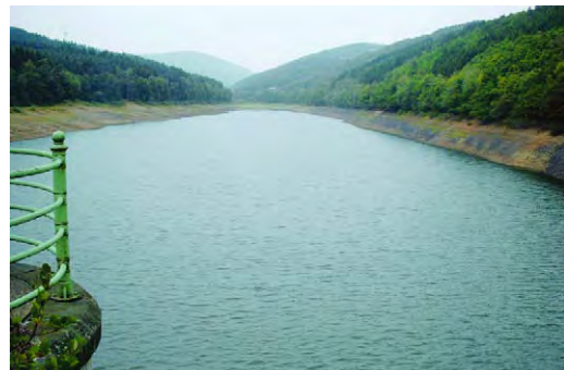
Abb. 4.2.2-2 Gestauter Wasserkörper der Oestertalsperre mit vegetationsfreien Uferbereichen
