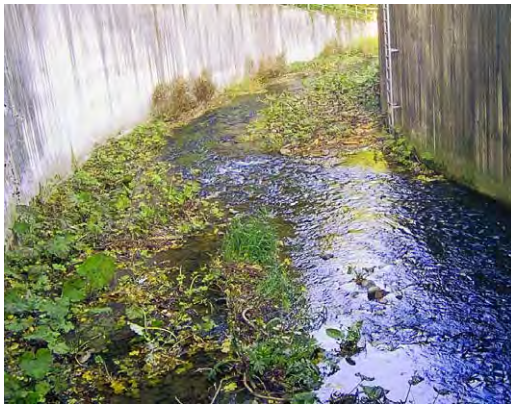
Abb. 3.1.5-2 Als Betonkastenprofil ausgebauter Ruhrabschnitt in Olsberg-Assinghausen (Quelle: StUA Lippstadt)
