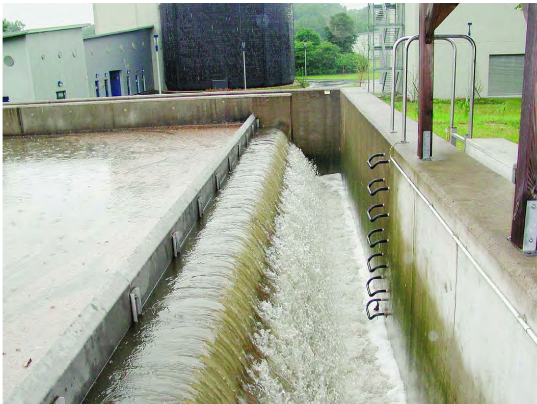
Abb. 4.1.2.1-6 Regenüberlaufbecken KA Iserlohn Baar- achtal (Foto: StUA Hagen)
