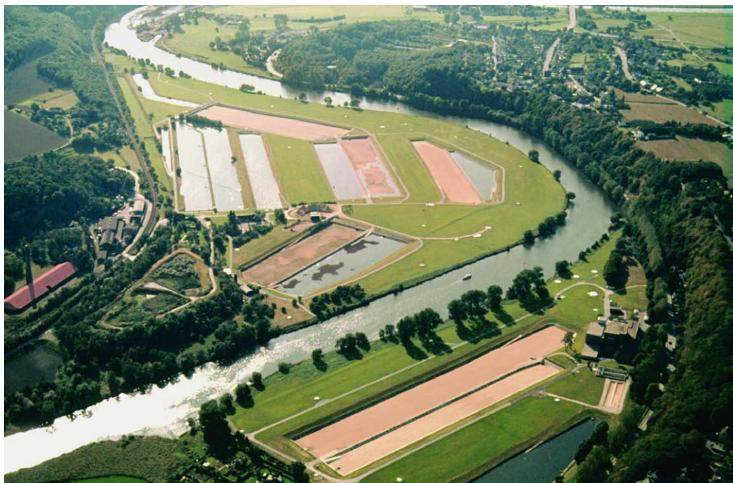
Abb. 2.2.1-1: Luftaufnahme der Wassergewinnungsan- lage Witten (Quelle: Ruhrverband)
