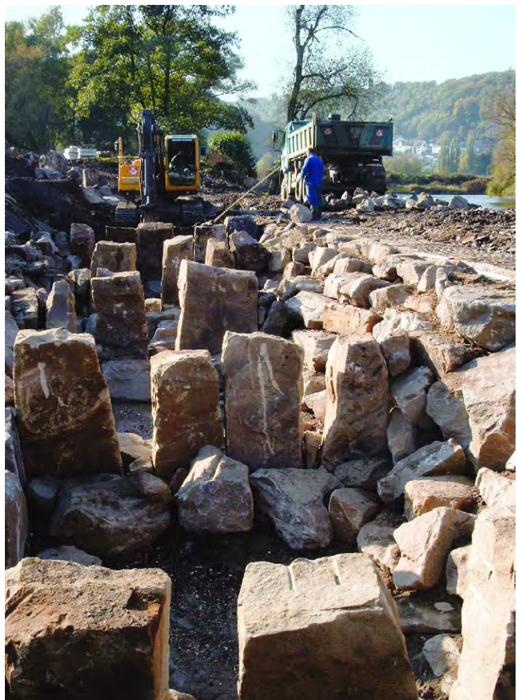
Abb. 3.1.6-1 Fischaufstieg am Krafthaus Harkortsee (unterer Abschnitt, Bauzustand, Foto: StUA Hagen)
