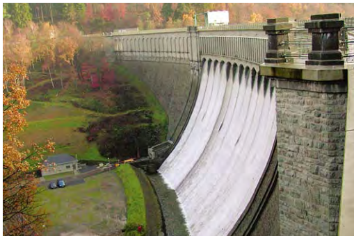
Abb. 4.2.2-1 Staumauer der Ennepetalsperre (Foto: StUA Hagen)
