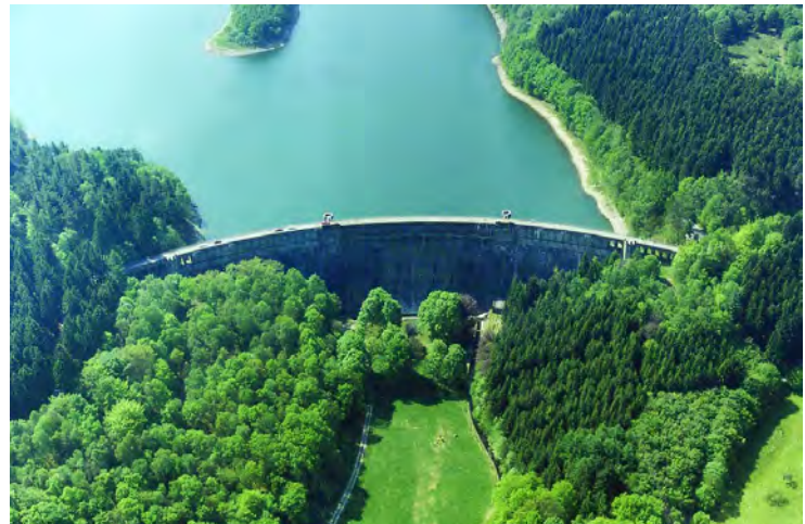
Abb. 1.6-1 Ennepetalsperre (StUA Hagen)
