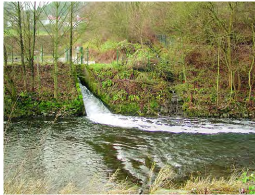
Abb. 3.1.1.4-1 Einleitung der Kläranlage Schalksmühle (Foto: StUA Hagen)
