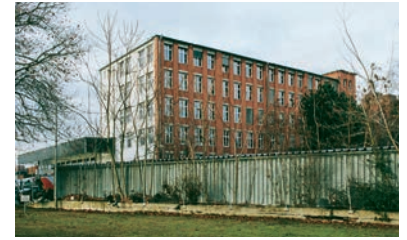
Das Lösch-Team von Arvato in Berlin hat weiter expandiert. Mittlerweile sollen dort rund 600 Menschen arbeiten – zum Beispiel in einer der oberen Etagen dieses Hauses in der Nähe des Flughafens Tegel.
